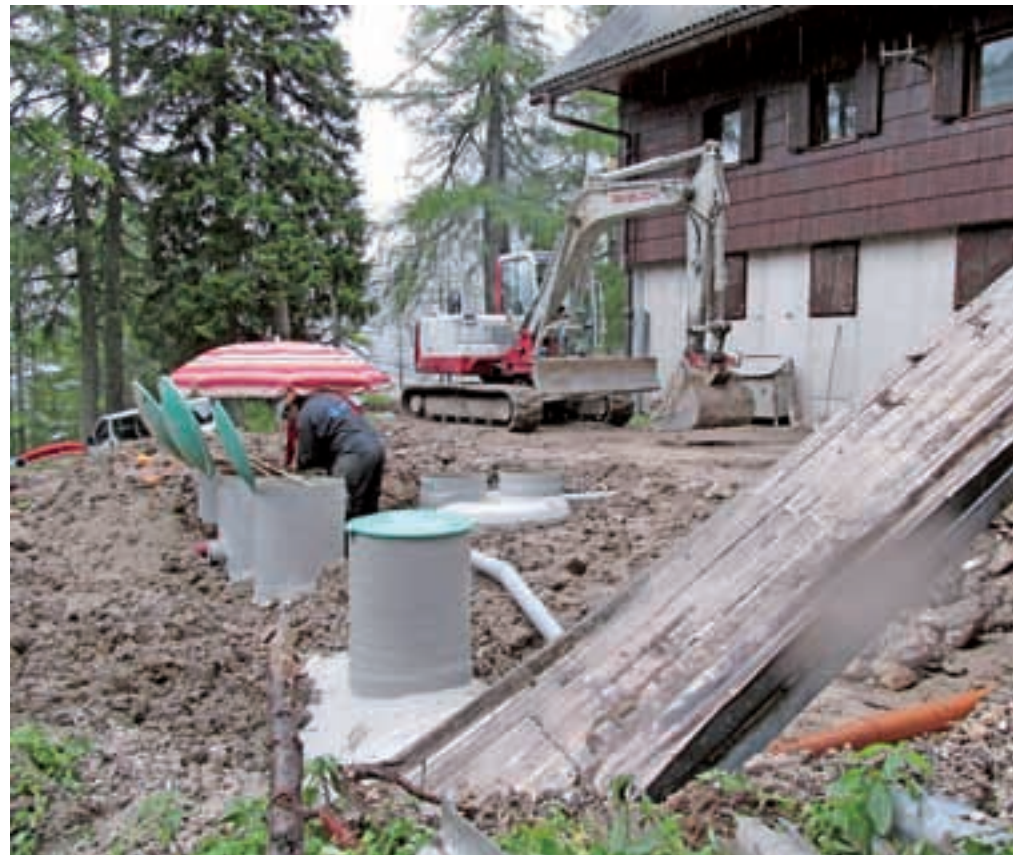
Erjavčeva koča na Vršiču je dobila malo komunalno čistilno napravo.
