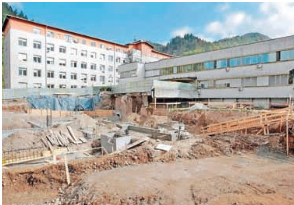
Gradbišče ob bolnišnici / FOTO: GORAZD KAVČIČ
